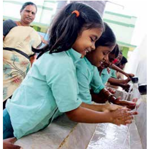
Die Kinder freuen sich über die neu erbaute Anlage zur Trinkwasserversorgung und zum Händewaschen, © Karl Kübel Stiftung / Ralf Tepel
